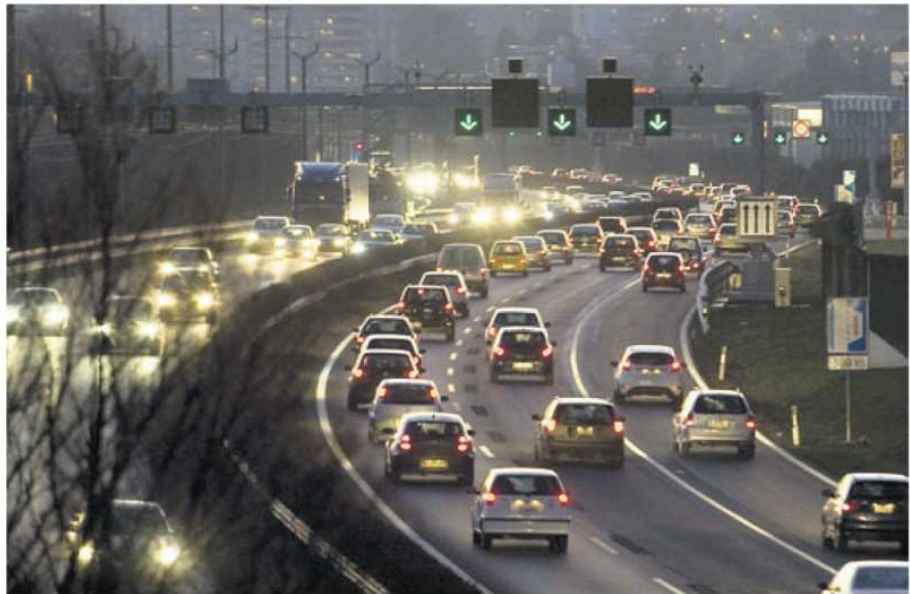
L'autoroute près de Morges est saturée. L'utilisation de la bande d'arrêt d'urgence comme troisième voie permet actuellement de fluidifier quelque peu le trafic en cas de forte affluence. ARC
